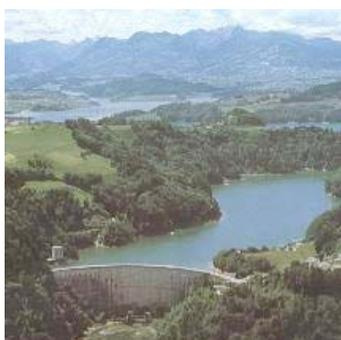
Construit entre 1944 et 1948, le barrage est constitué de 250000 m<sup>3</sup> de béton. Il est actuellement exploité par groupe E
